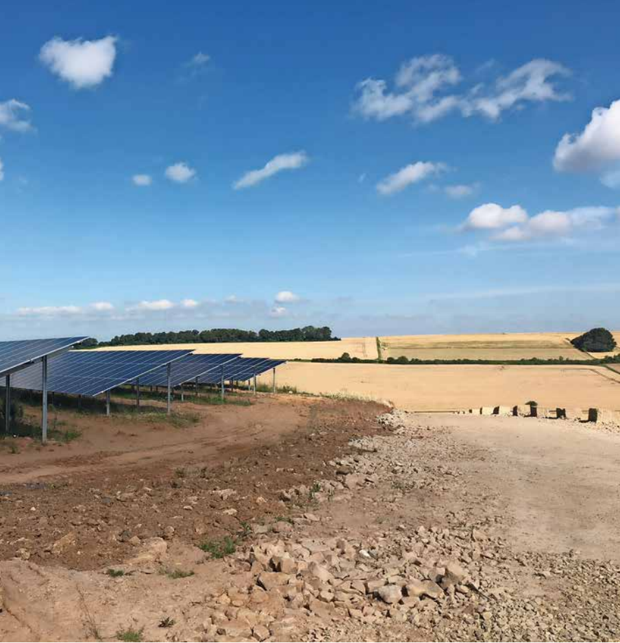
Solarpark Kersch kurz vor der Fertigstellung.
