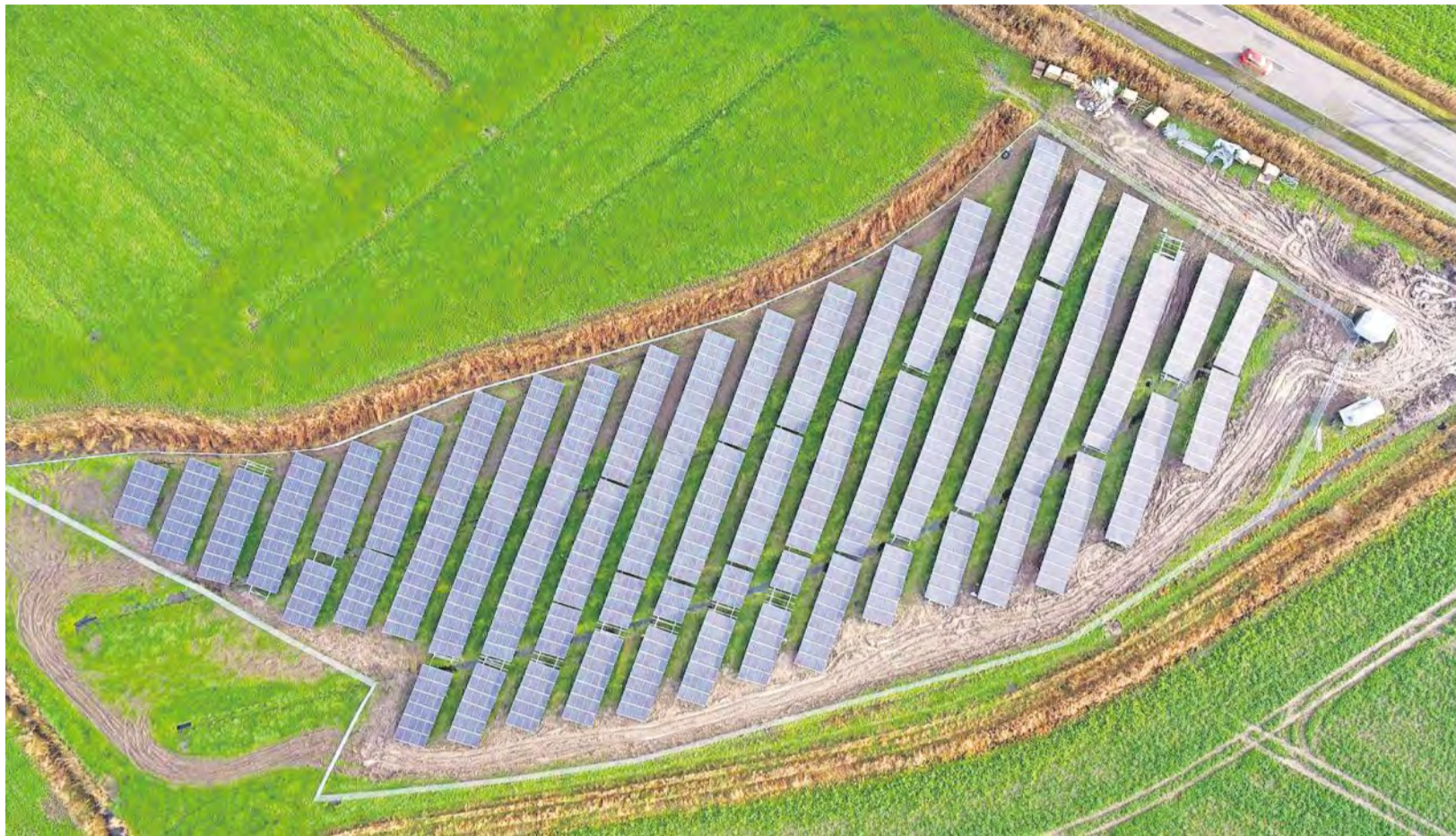
Im Solarpark an der Otterndorfer Umgehungsstraße wird mit rund 0,75 Megawatt zu Spitzenzeiten so viel Strom produziert, wie 200 Vier-Personen-Haushalte verbrauchen. Die Anlage ist seit Februar ans Stromnetz angeschlossen. Fotos: WI Energy
