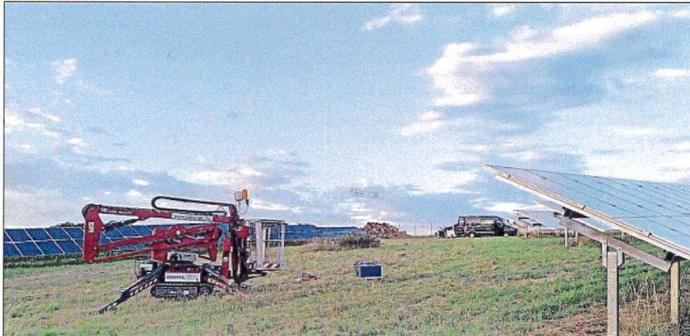
Ein Steiger wird aufgebaut, um mit einer Kamera den Überblick über den PV-Park zu haben. FOTO: WI ENERGY GMBH
