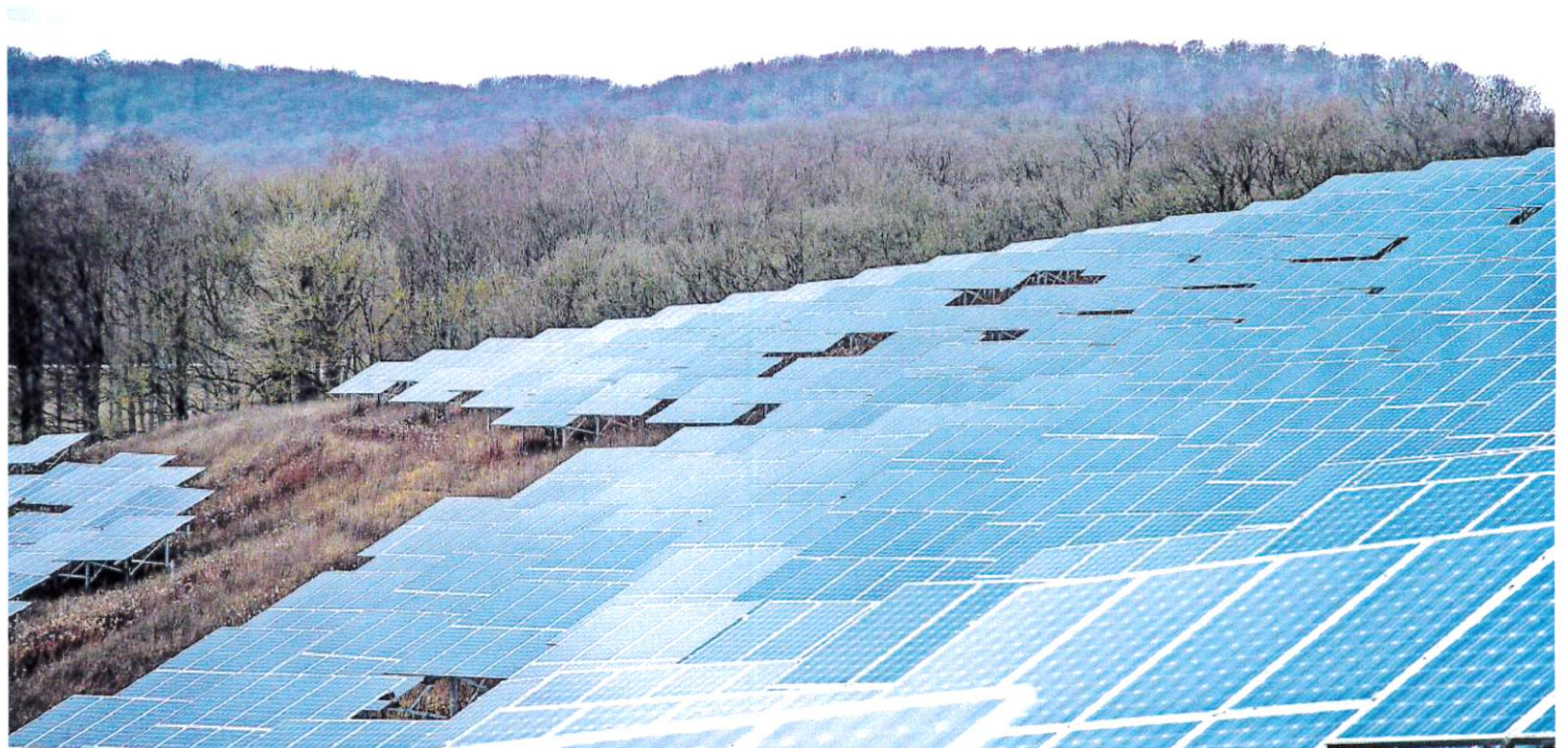
Solarmodule wie hier in Heide könnten auch in der Gemarkung Hotteln Einzug halten.
