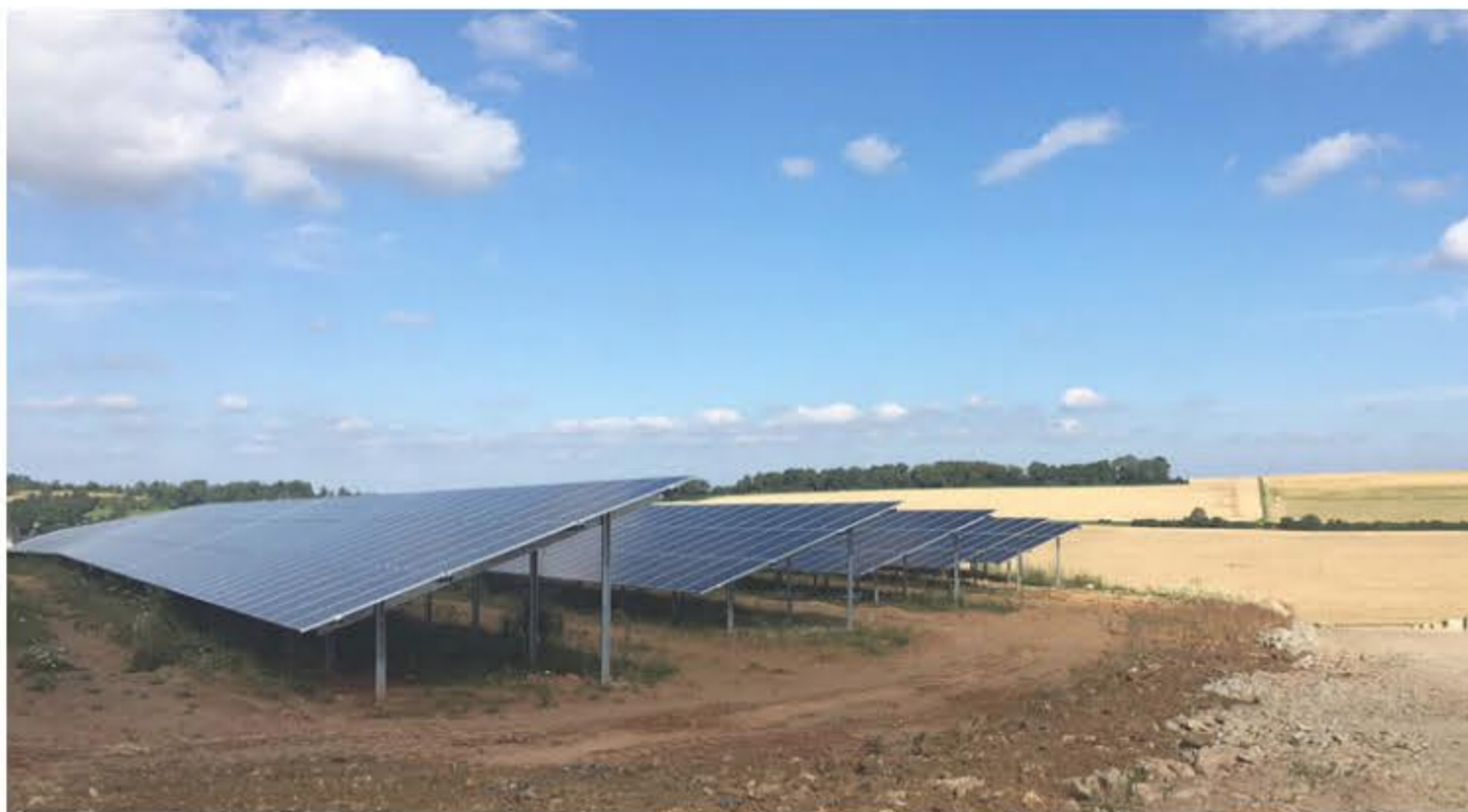
© WI Energy GmbH | Solarpark Kersch kurz vor der Fertigstellung
