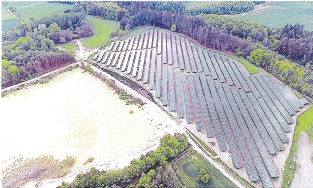
Die beiden Unternehmen WI Energy GmbH und ENAGRA GmbH & Co. KG haben nahe Arenrath eine Photovoltaik-Anlage gebaut.
